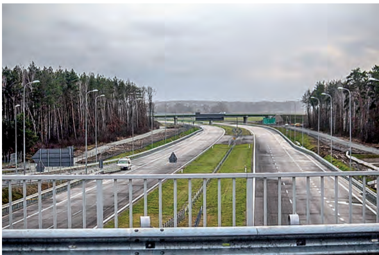
▲ Droga ekspresowa S5 w okolicach Leszna jest już w ostatnim stadium budowy.
