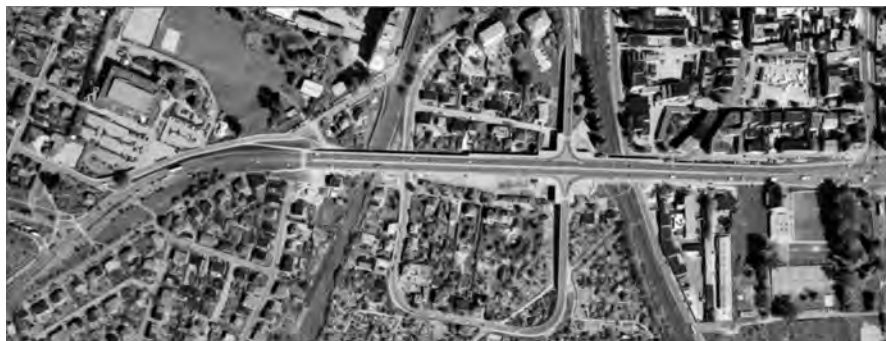
Wiadukt im. Stefana „Grot” Roweckiego
